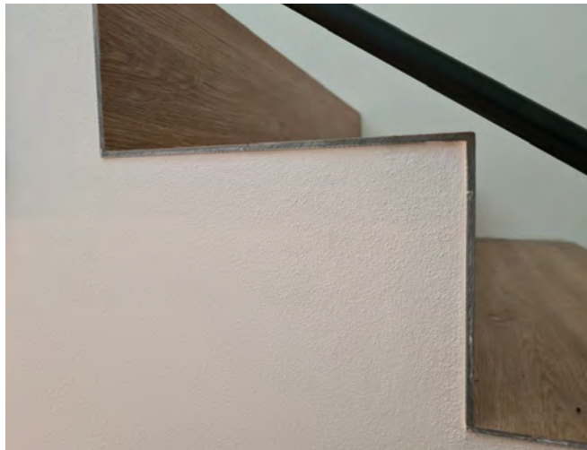
Obložení schodů vinylovou podlahou
